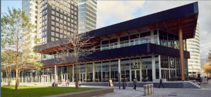
ABN Amron Circular Pavilion Hollannissa. Rakennuksessa on toteutettu kiertotalouden periaatteita mm. seuraavin tavoin:
